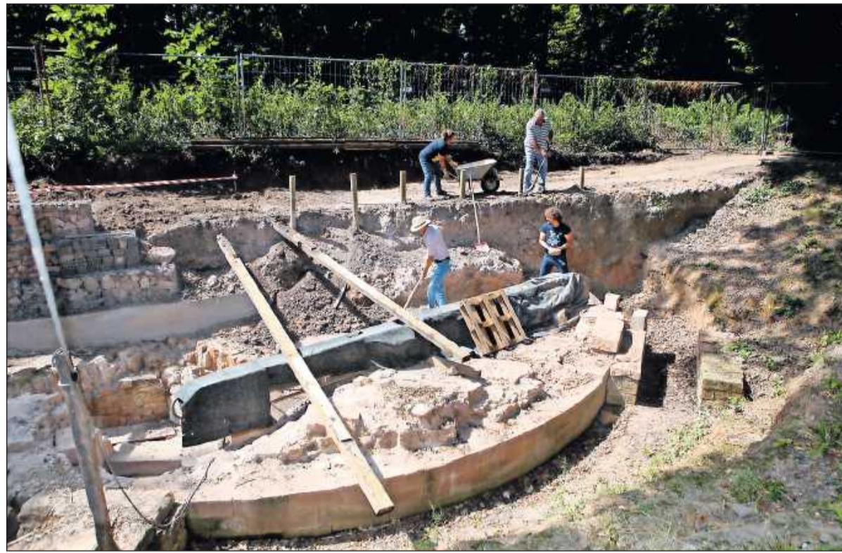
Oberirdisch ist noch nicht viel zu erkennen vom extrem seltenen Rundturm der Lunette 41, aber unterirdisch macht die Anlage sehr viel her. FOTO: IVERSSEN
